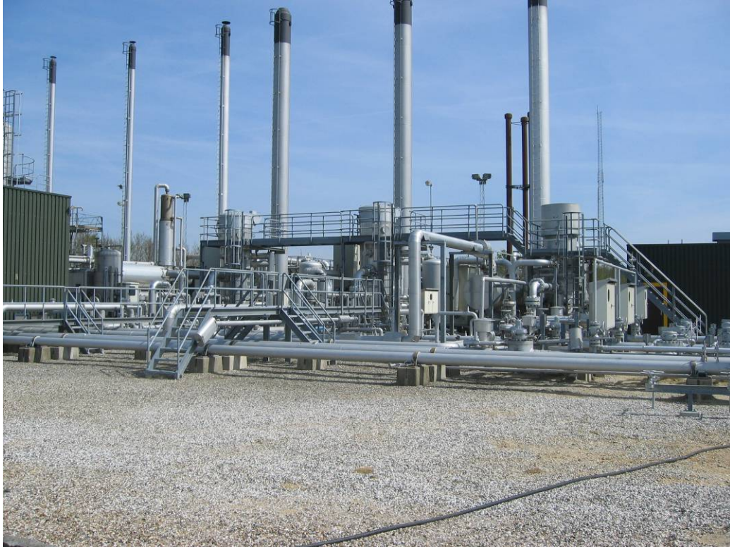
Figur 8.3 Gasforvarmere
